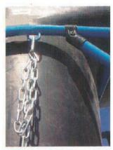
Cadena de ducto superior se cuelga con vuelta en soporte metálico
